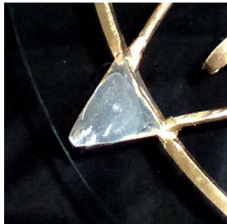
Рис. 10. Пятак крепления стекла к стойке
